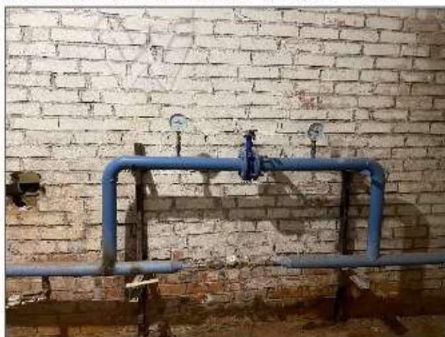
Рисунок 5.3.5 – Водомерный узел и прибор учета СВК-20У
