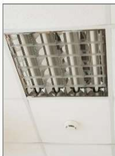
Рисунок 5.3.16 – Основное светотехническое оборудование
