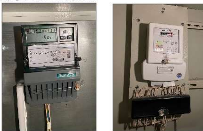
Рисунок 5.3.3 – Приборы учета электрической энергии
