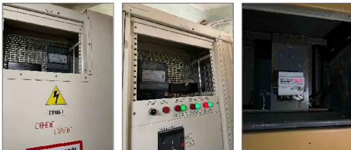
Рисунок 5.3.9 – Приборы учета электрической энергии
