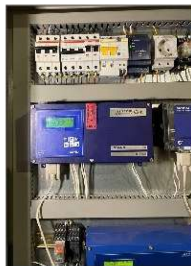
Рисунок 5.3.4 – Тепловой узел и тепловычислитель ВЗЛЕТ
