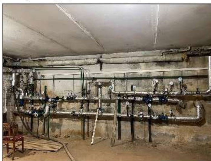
Рисунок 5.3.4 – Тепловой узел и тепловычислитель ВЗЛЕТ
