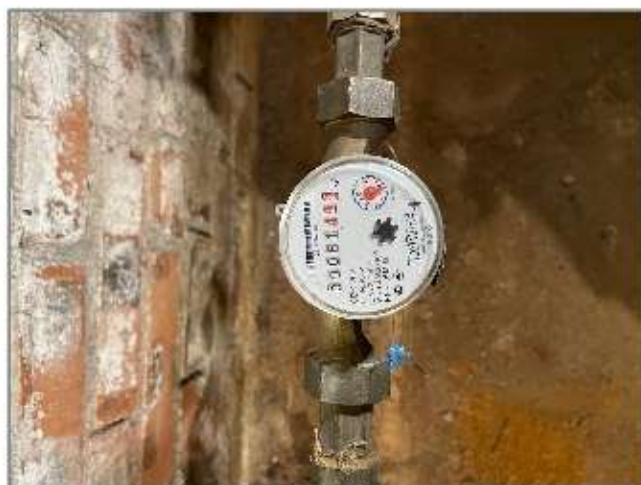
Рисунок 5.3.5 – Водомерный узел и прибор учета СВК-20У
