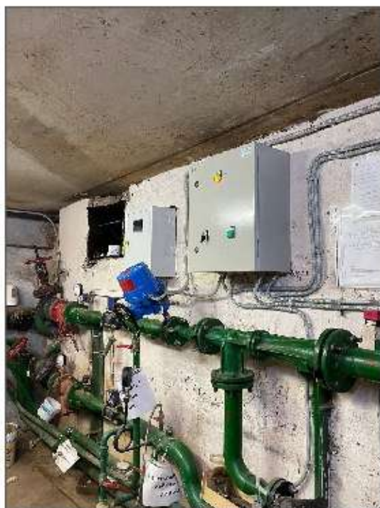
Рисунок 5.3.10 – Тепловой узел и тепловычислитель ВЗЛЕТ
