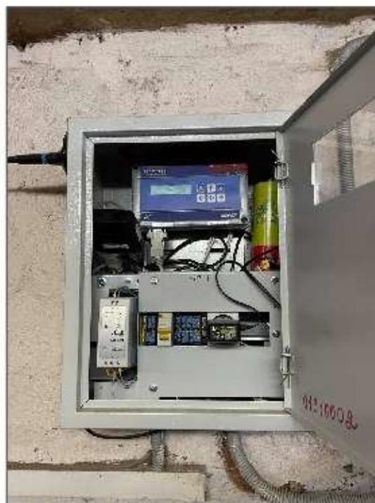
Рисунок 5.3.10 – Тепловой узел и тепловычислитель ВЗЛЕТ
