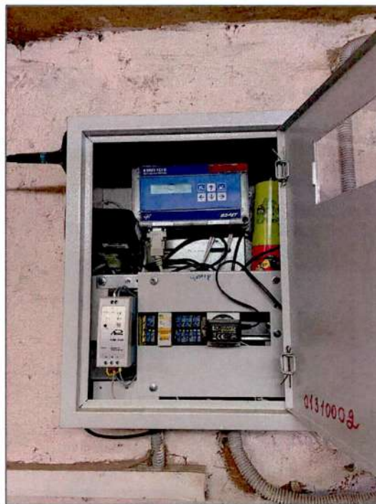
Рисунок 5.3.10 – Тепловой узел и тепловычислитель ВЗЛЕТ
