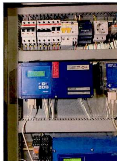
Рисунок 5.3.4 – Тепловой узел и тепловычислитель ВЗ/ЕТ
