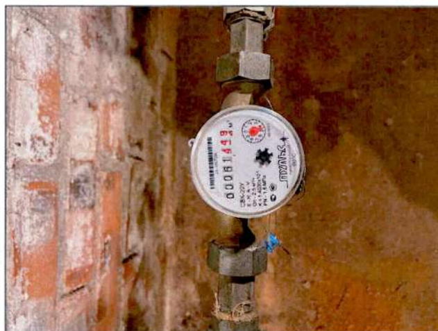
Рисунок 5.3.5 – Водомерный узел и прибор учета СВК-20У
