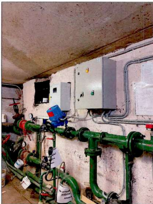
Рисунок 5.3.10 – Тепловой узел и тепловычислитель ВЗЛЕТ
