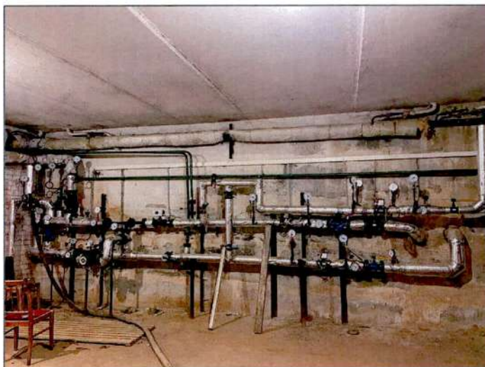
Рисунок 5.3.4 – Тепловой узел и тепловычислитель ВЗ/ЕТ
