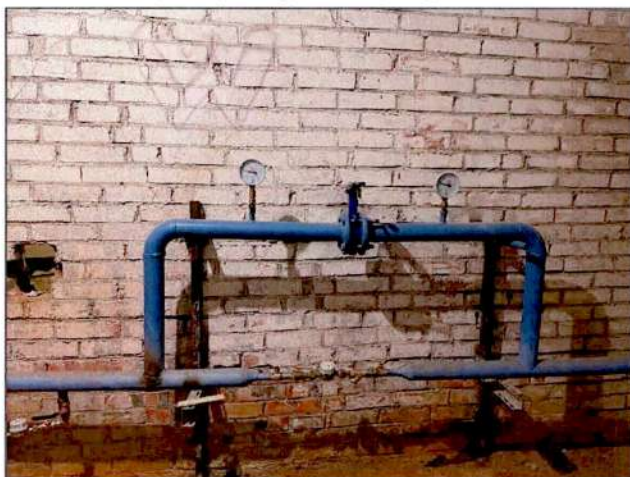
Рисунок 5.3.5 – Водомерный узел и прибор учета СВК-20У
